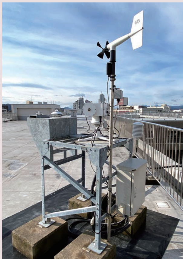
図3 日射計などが設置された気象観測装置
