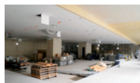
1階アメニティーエリア 現状
