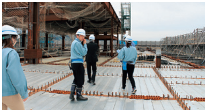
屋上です。板の下は…
