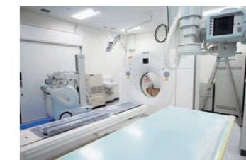
処置室にCT装置を設置
