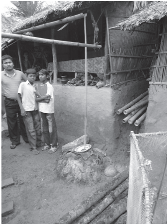
写真2 盛り土をした上に建てられた住居と雨水を溜める装置
