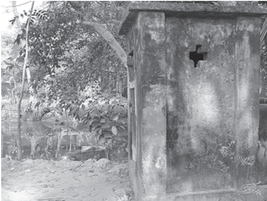
写真 1 ため池のそばに設置された掘り込み式トイレ
