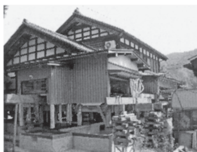
e) リフトアップ工事中
