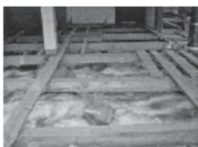
b) 床板を剥がし、石灰を撒いて消毒・乾燥中。
