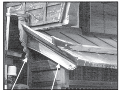
破風留め 破風板 写真3
