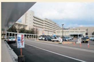
改修された附属病院駐車場
