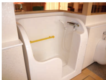
シャワーユニット ・元気な年少児のため衛生面からシャワーユニットを設置しました。
