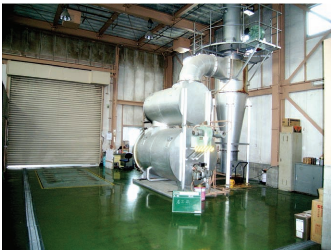
撤去された焼却炉の全景
