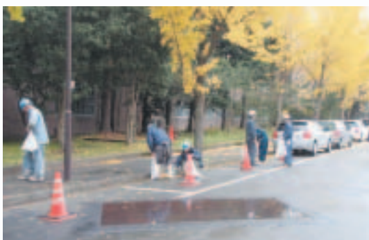
工事関係者による一斉清掃
