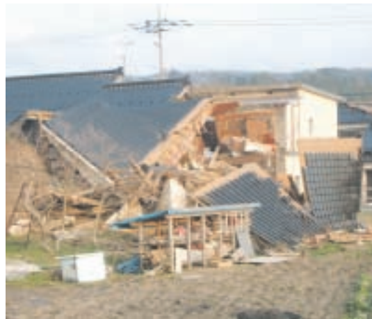
能登半島地震による倒壊家屋
