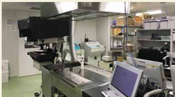
図2 新病理部・切出し室。下方気流型プッシュプル換気装置
