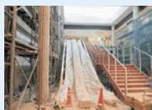
エスカレーター増築エリア 工事状況
