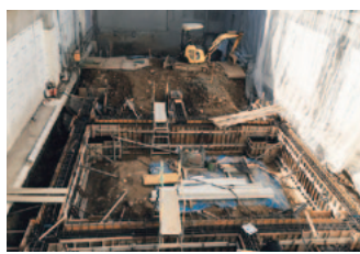
エスカレーター増築エリア 工事状況
