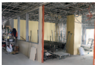
外来エリア2階 工事状況
