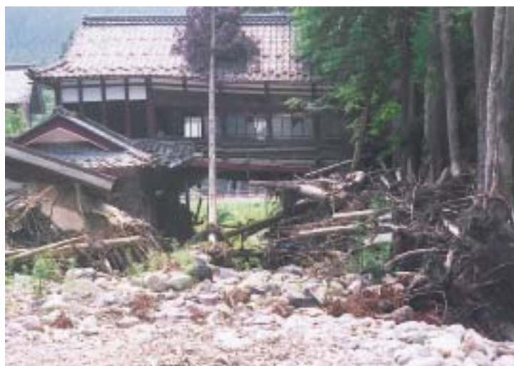
池田町の被災した民家
