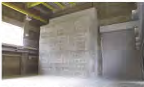
▲高さ7.25m、幅8.1m、頂部で4,000kNの載荷能力を持つ反力壁
