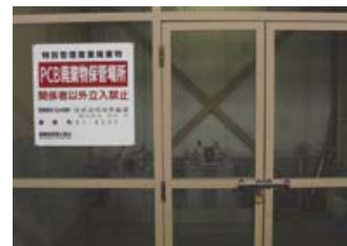
松岡キャンパスPCB廃棄物保管場所
